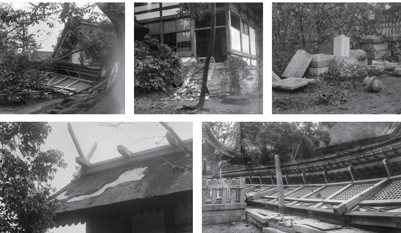
昭和9年(1934)9月21日 室戸台風 本殿桧皮葺が吹き剥がされ、瑞籬の塀は薙ぎ倒され、折枝による建物の損壊、倒木により石燈籠が破壊された様子(ガラス乾板)
