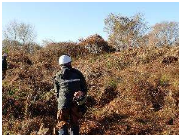
2025/12/23 刈払機で全面除草
